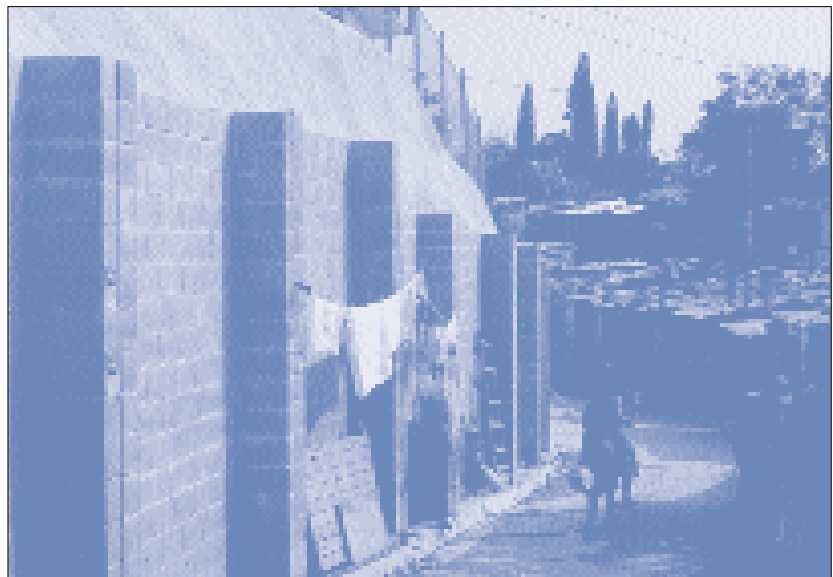
Neu errichtete Stützwand zur Verhinderung von Erdrutschen
